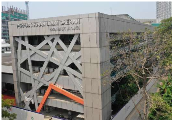
Gambar 3 Perpustakaan Umum Daerah Provinsi DKI Jakarta sebelum direnovasi
